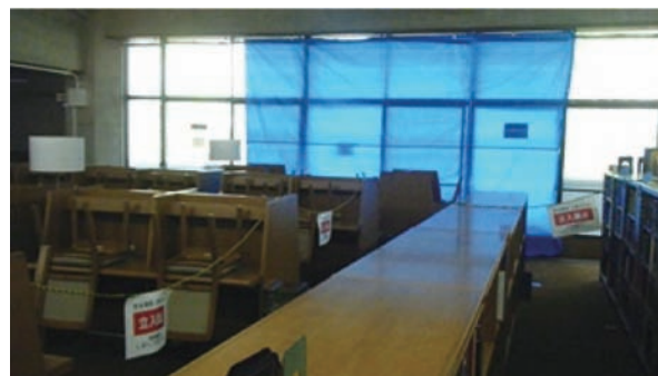
写真5 窓枠損傷による立入禁止区域
