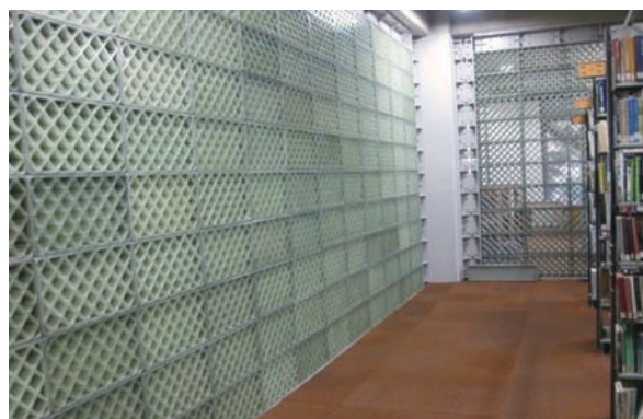
写真2 FRP ブロック耐震壁
