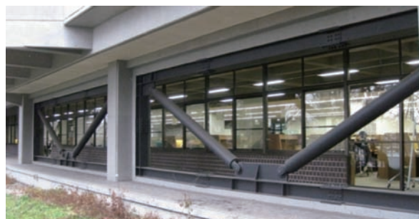
写真3 鋼管ブレース
